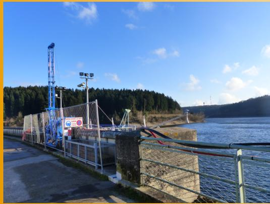
Plusieurs opérations seront engagées pour ce chantier : renforcement de la culée rive gauche, mise en place d'un garde corps en métal au dessus du déversoir, ajout d'une chaîne de pendules inversés (instrument de mesure visant à étudier les mouvements de la voûte du barrage), mise en place d'une drome flottante dans la retenue, et création d'une passerelle d'auscultation au pied du barrage qui garantira un accès sécurisé aux agents en charge des relevés.
